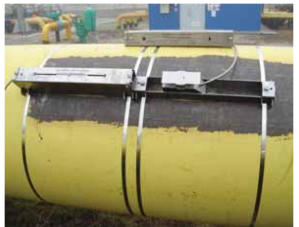
Процесс установки накладных датчиков
